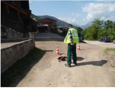
Attività di verifica dei pozzetti di fognatura
