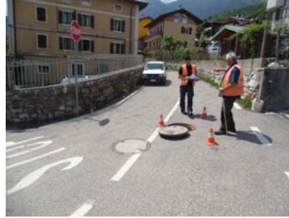
Attività di verifica dei pozzetti di fognatura
