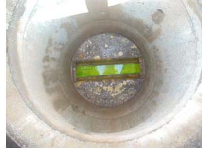
Passaggio del tracciante nel pozzetto
