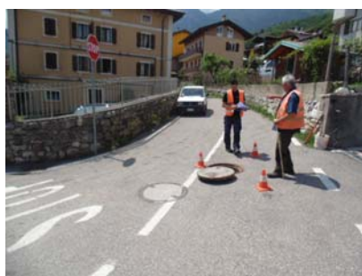
Attività di verifica dei pozzetti di fognatura
