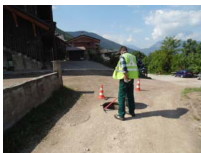
Attività di verifica dei pozzetti di fognatura
