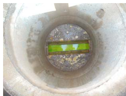
Passaggio del tracciante nel pozzetto
